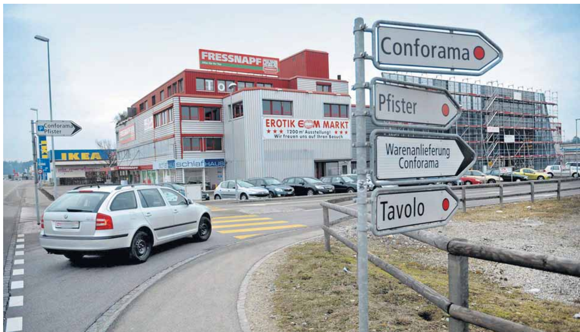
Hinten Ikea, vorne Conforama und Pfister – und dazwischen Diga: Noch wird am Gebäude, in das das neue Möbelhaus einziehen will, eifrig gebaut.
